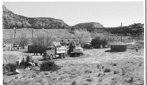
ウラン汚染土を取り除く除線の様子 (ナヴァホ保留地)
