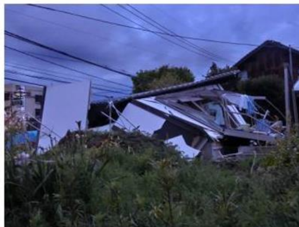
写真 3.3-1 4/15 時点では壁が外れただけの家屋（左）が本震で倒壊（右）した例
