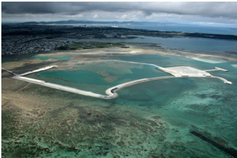
2008年5月8日 1区の護岸が8割がた完成 サンゴ・海草は生埋め
