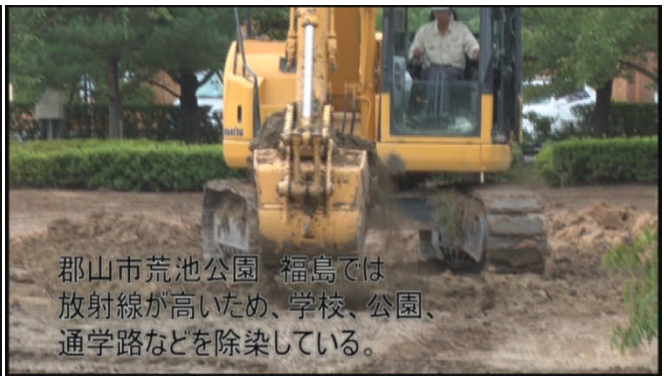
郡山市の公園での除染作業。 福島県では、放射線が高いため、公園、学校、通学路などを除染している。
