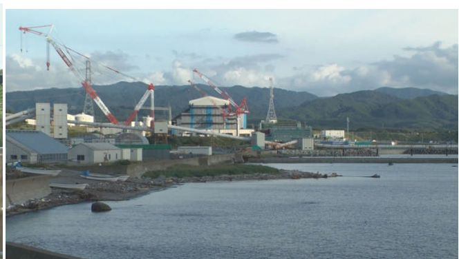
下北半島最先端の大間町に建設中の大間原発(2011年8月)
