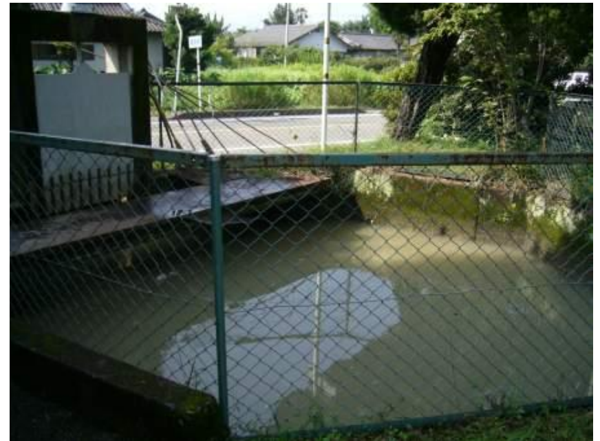
農地に水を供給する相良村・六角水路
