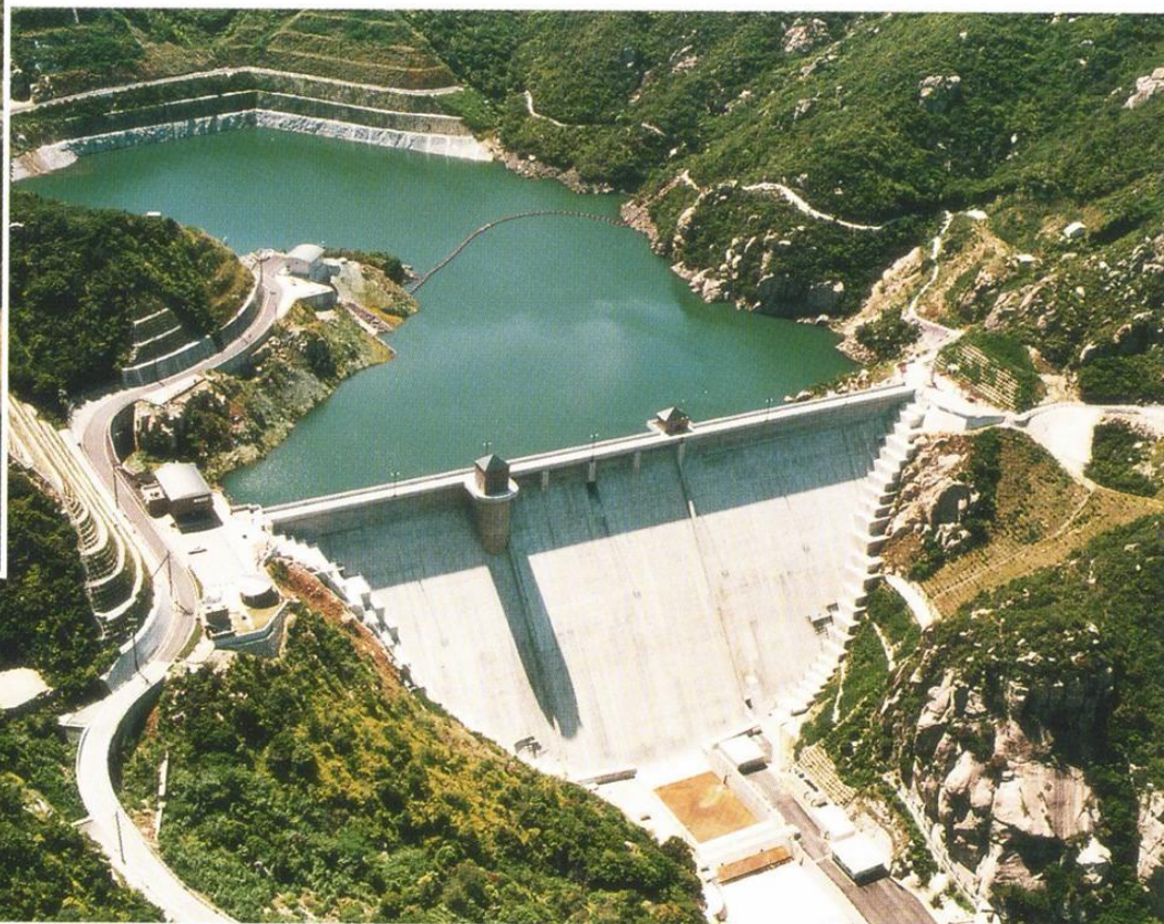
平成9年に完成した吉田ダム
