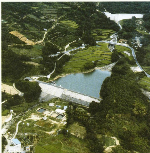
昭和34年に完成した内海ダム
