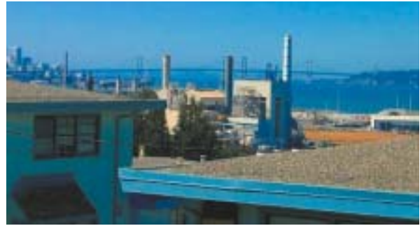
写真1 発電所と隣接する住宅 (向こうに見えるのはベイブリッジ)
