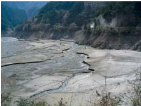
写真3 水窪ダムの堆砂（2004年3月29日） 水窪ダムサイト上流1.6km地点。このあたりから粘土状の堆砂が始まる。
