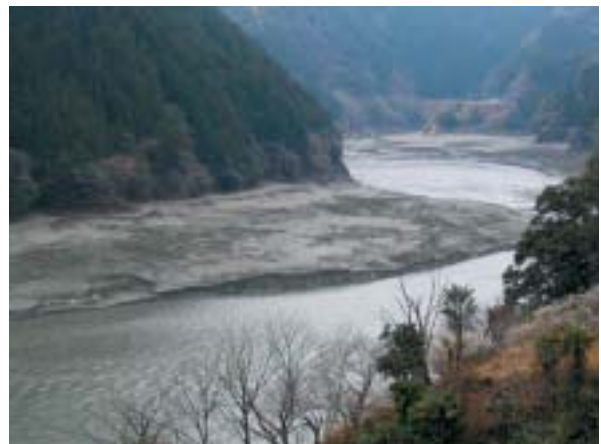
写真4 佐久間ダムの堆砂（2005年3月4日） 愛知県富山村地内（JR飯田線大嵐駅西方）佐久間ダムサイトより16km上流。流砂促進事業 * 見学会（天竜漁業協同組合主催）に参加撮影。
