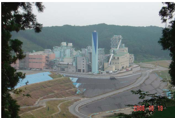
日の出町ニツ塚廃棄物最終処分場内のエコセメント工場全景
