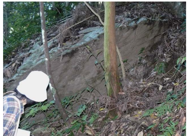
図8 地滑りを示す樹木の根曲がり、背後には安山岩の転石。この上に処分場を建設しようとしているのだ。
