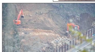
(左写真) 転流工出口付近の準備工事の様子。厚い崖錐堆積物が見られる。透水性が大きく、不安定なため、崩壊なども懸念される
