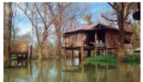
ダム建設の影響で浸水した家屋(ダム上流のKbal Romeas村)
